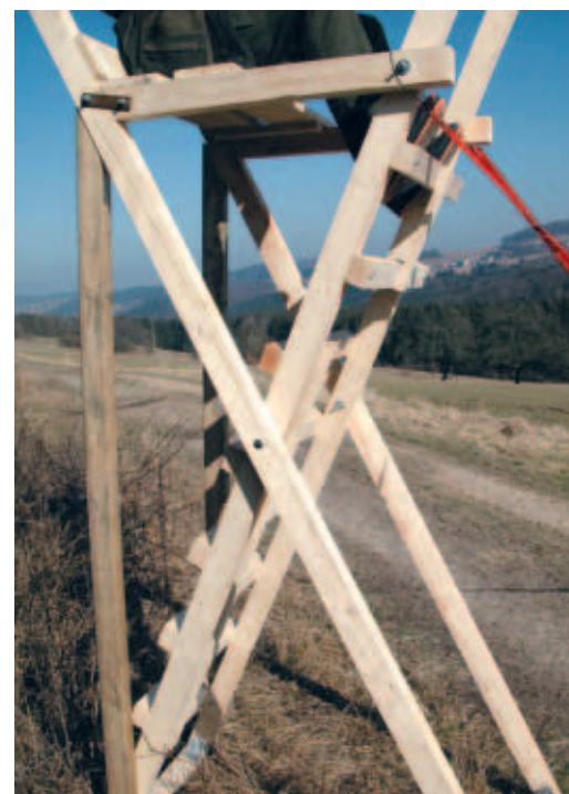
Ein sicherer Stand der Leiter ist erst dann gewährleistet, wenn sie nach allen vier Seiten mit Bodenankern abgespannt wird
