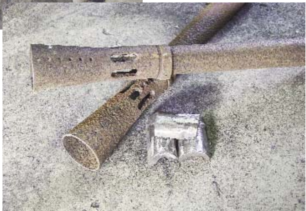
... und hier sind die Rohrstücke blankgeschliffen. Man sieht, es ist genügend Material vorhanden.
