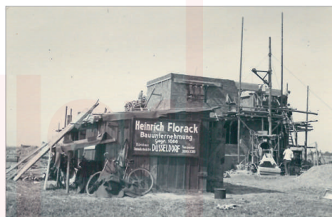
1934: Bauarbeiten an der Villa Haus Pesch
