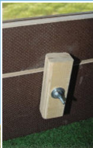
Durch Flügelmuttern an den Fensterriegeln lassen sich diese bei Bedarf nachstellen.
