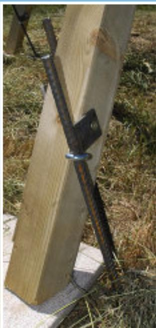
1,5 Meter lange Erdanker halten die starken Hauptpfeiler am Boden.
