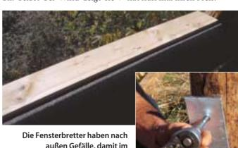
außen Gefälle, damit im geschlossenem Zustand kein Wasser eindringt. Die Acrylfenster lassen sich nach oben aufziehen. Durch die Flachstahlanker steht der Hochsitz selbst in windigen Gebieten sicher OTOS: MARKUS WÖRMANN (3), JULIA NUMSSEN (1), BURKHARD FISCHER (2)
